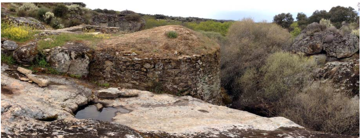
Figura1 Molino em Sobradillo, Salamanca. Cobertura vegetal em abóbada por aproximação das linhas
