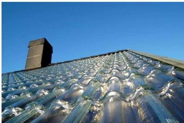
Figura 15 Teça de Cristal Solar para cobertura captadora com recente patente por parte da empresa sueca SolTech Energy
