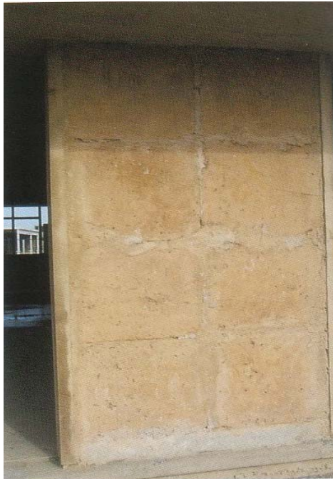
Figura 11 Muro de adobe prefabricado de 50 cm no edificio Savatierra, Rennes, Francia
