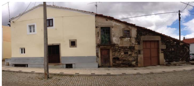
Figura 7 Coberta tradicional trabalhando como cobertura captadora Palazçoula
